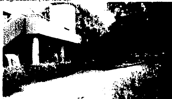
Fotografía 3. Aquí en esta toma se ve con más claridad el desnivel y una parte del edificio, el sistema de piso es a base de losa nervada, tomada de sur a norte desde la colindancia.
