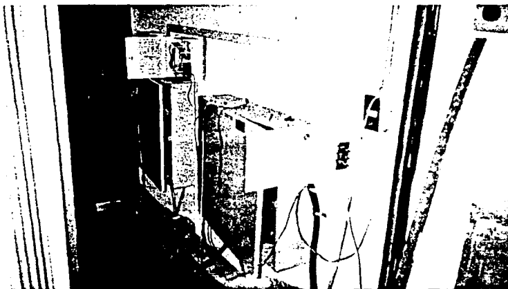
Figura B6.- Llegada del Lanplex 2500 del Instituto de Geografía (puerto 2) al enlace principal en el Instituto de Geofísica.
