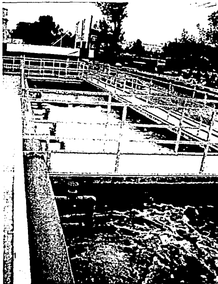
Fotog II 14 Planta de Tratamiento de Aguas Residuales para su reuso en industrias de productos químicos Cortesía ISSISA
