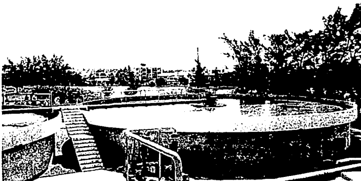
Fotog. II 21 Planta de Tratamiento de Aguas Residuales para su reuso en riego de áreas verdes Cortesía: MC C.G.P.
