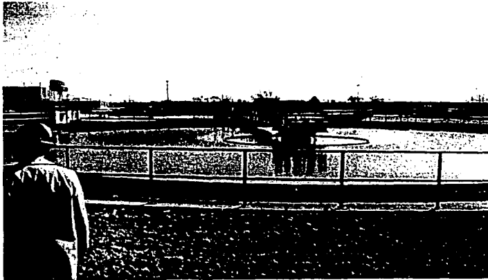
Fotog. II.8 Planta de Tratamiento de Aguas Residuales para su reuso en recarga de mantos freáticos Cortesía ISSISA
