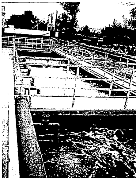
Foto II 14 Planta de Tratamiento de Aguas Residuales para su reuso en industrias de productos químicos Cortesía ISSISA
