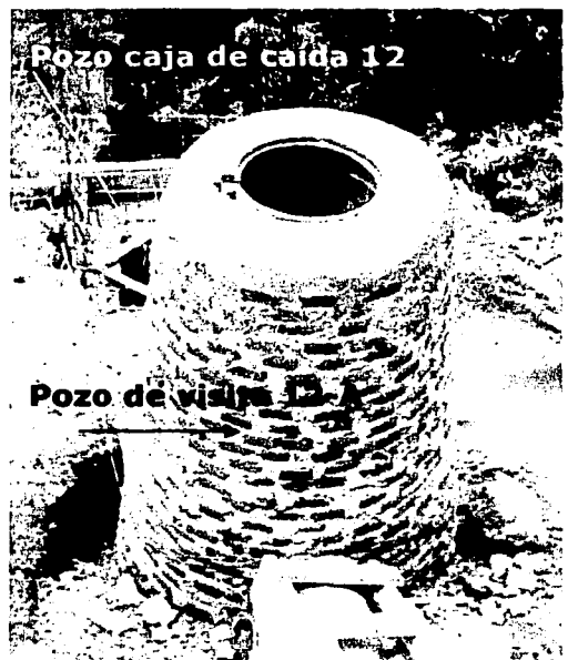
Fotografía 16. Pozo de visita 13-A y caja de caída 12 de la red pluvial del condominio I.
