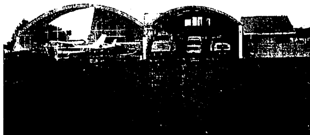
Foto 3. vista desde la plataforma de aviación comercial, del lado derecho está el C.R.E.I. con un tanque cisterna, una ambulancia y un vehículo utilitario, sin contar con oficinas, dormitorios ni otro servicio. Del lado izquierdo está el hangar de F.B.O. que atiende a avionetas exclusivamente, pudiendo ser de carácter internacional.
