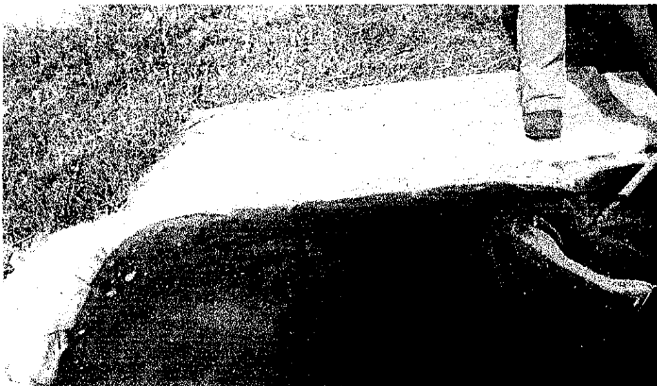
Foto 4. Laguna facultativa. Retiro de nata por medio de una cuchara de malla. Labor realizada diariamente.
