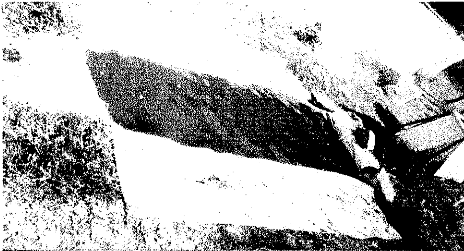
Foto 3. Laguna facultativa, se puede observar el revestimiento utilizado en el sistema lagunar para evitar filtraciones.
