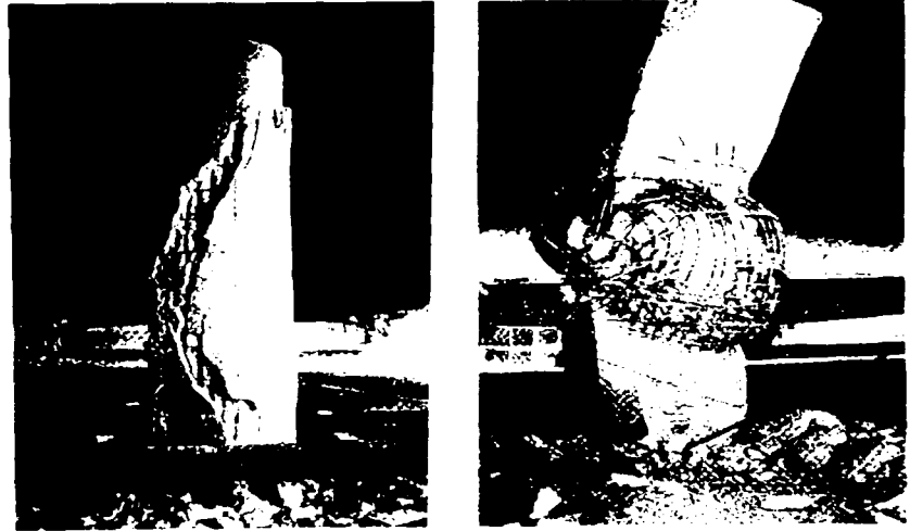
Figura 1.13 Falla por cortante en columnas
