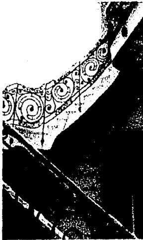
17. Vista lateral de la escalera circular posterior a la restauración.
