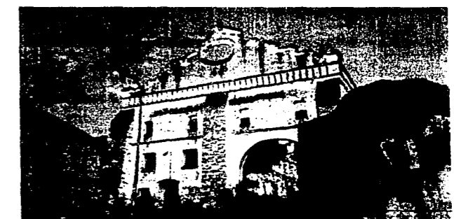
Vistas de la fachada oeste del Ingenio de San Carlos
