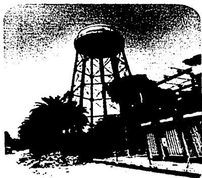
Fig. A.34 Construcción del Centro Nacional de las Artes.
