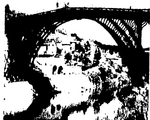
Puente sobre el río Severn en Coalbrookdale, Inglaterra. Proyecto y obra de J. Wilkinson, T. Pritchard y A. Darby (1777–1778). El puente estaba formado de cinco segmentos de arco paralelos en cada lado (diez piezas en total) y arrojaba una luz libre de 30.5 m. Cada segmento de arco estaba fundido en una sola pieza, y se unían en la cumbre por medio de una clave remachada articulada, también de hierro.
