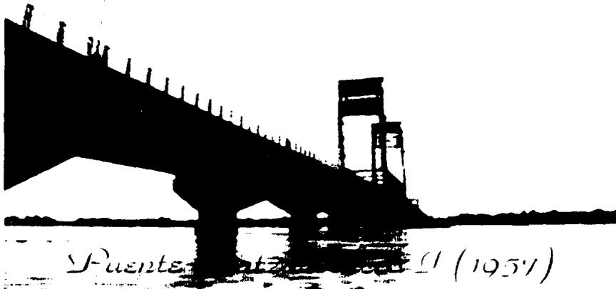
Foto 1.2. Puente con cimentación a base de cilindros.
