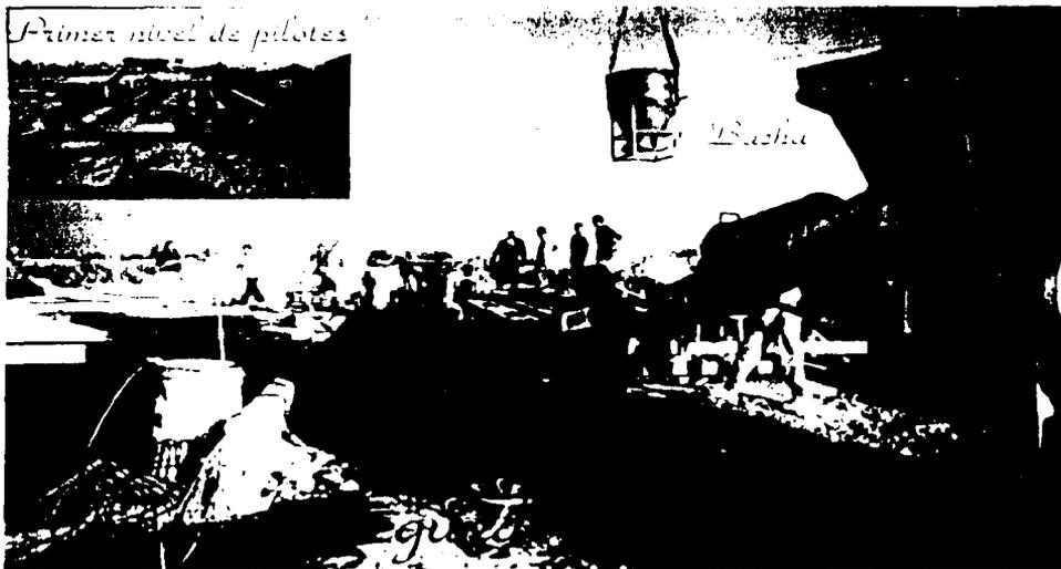
Foto V.19. Colado de un segundo nivel de pilotes.
