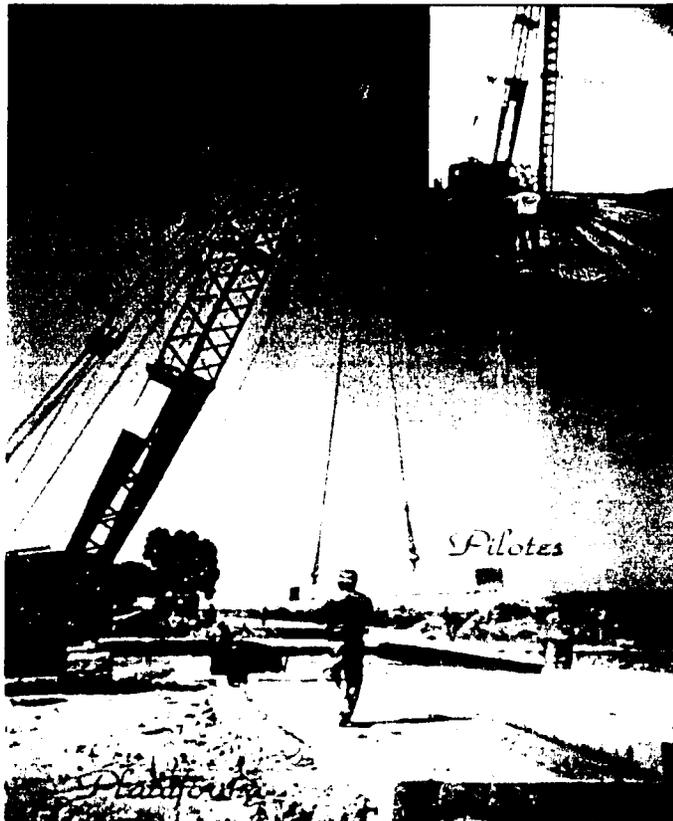
Foto V.21. Se despegan los pilotes de la plataforma de colado.
