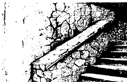
Fotografía 15.- Escaleras de acceso
