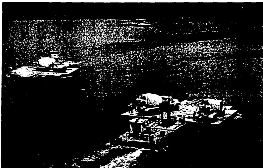
Figura V-8. Transporte de concreto en ollas revolvedoras sobre remolcadores
