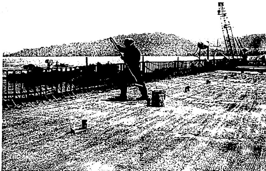
Figura VI-5. Aplicación de membrana de curado
