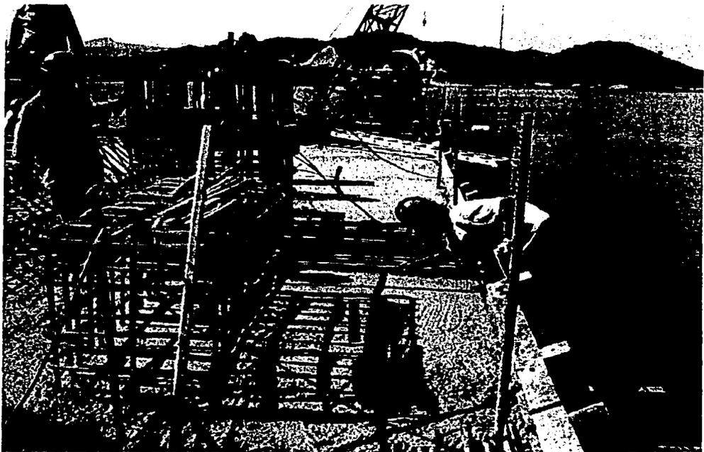
Figura VI-1. Nivelación (enrasado) de concreto con regla de madera
