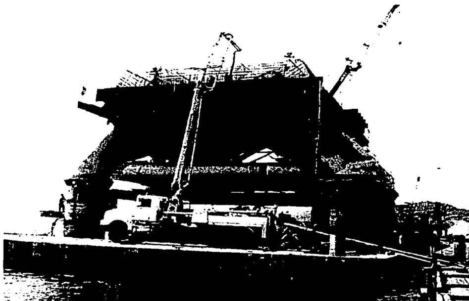
Figura V-6. Transporte de concreto con bomba sobre camión
