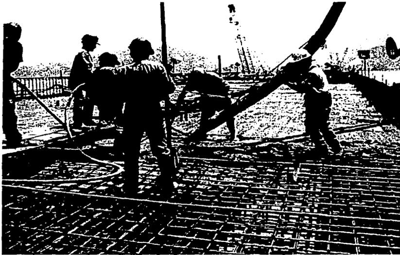
Figura V-9. Colocación de concreto bombeable
