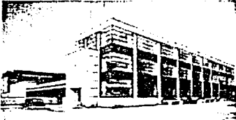
Fábrica Fagus, 1911. Walter Gropius y Adolf Meyer. Estructura en cantiliver con apoyos puntuales.
