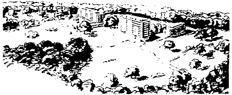
Bloques de vivienda en St. Leonard's Hill, 1935.
