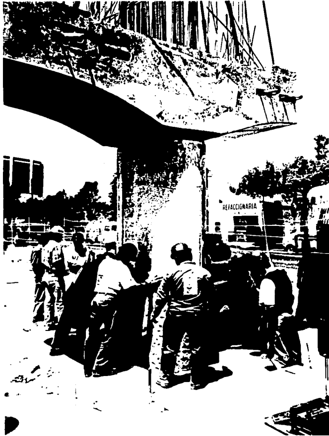
Fig. 4.2.4 Montaje de columna
