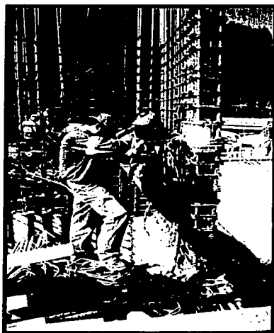
Fotografías 6.3.4 Armado de muros de contención y soldadura en acero de refuerzo en \emptyset \geq \text{No } 8=1''=2.54 \text{ cm.} en zapatas, columnas, contrarabes y muros.
