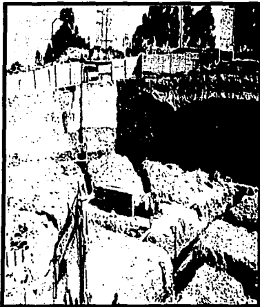
Fotografías 6.3.1. - Preliminares. Nivelación, corte y excavación, de cepas para cimentación.
