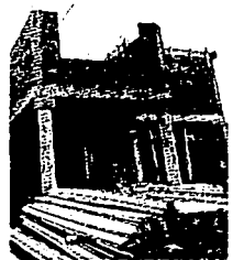
b) Aplicación de la vigueta y bovedilla en casa habitación
