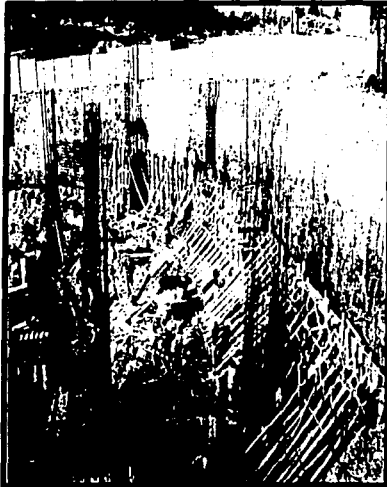
Fotografías 6.3.3 Armado, cimbrado y colado de cimentación. Relleno de cepas y cimbra en muros de contención.
