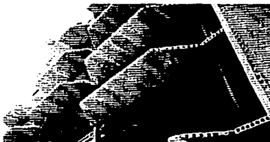
Fotografía 4.1.2.4 Modulación de los tableros alveolares por proyecto para dar continuidad a la losa.
