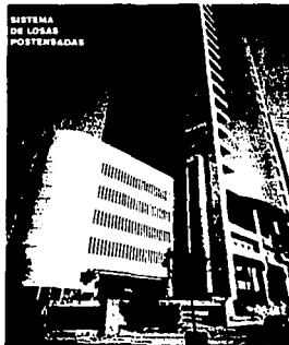
Fotografía 4.2.1 Edificio construido con losas postensadas; exigencia de la arquitectura moderna.
