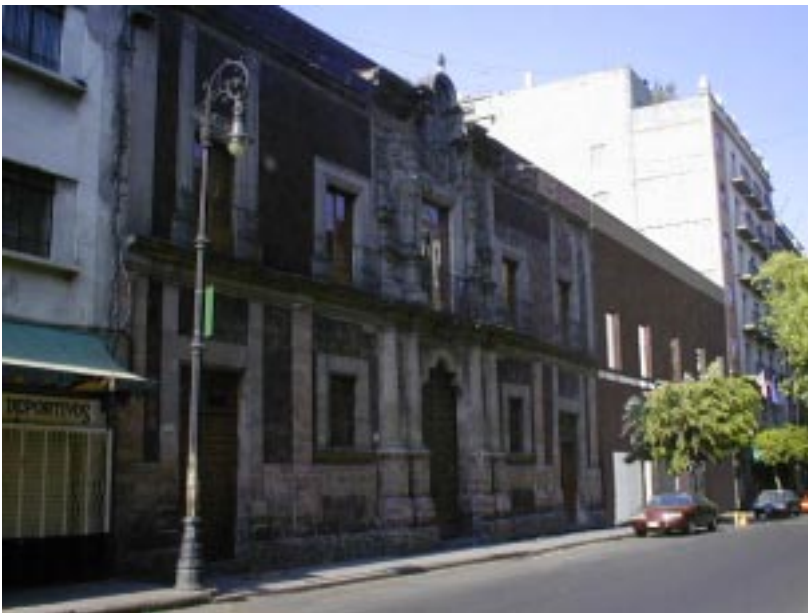
1 y 2. Vistas de la Calle de Donceles, Fachada Norte.
