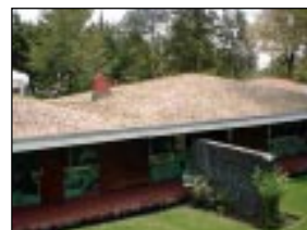
Fig. 2.29 y 2.30.- Trabajos de mantenimiento de áreas verdes y naturación en azoteas.
