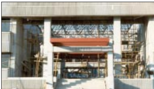
Fig. 2.38 y 2.39.- Trabajos de construcción del CENAPRED.
