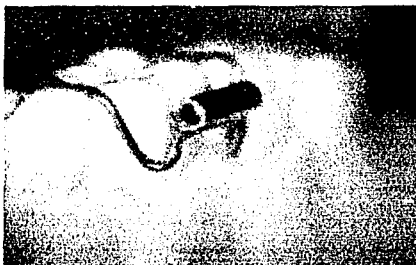
Fig. 3-3 gancho adams con tubo soldado en el puente.
