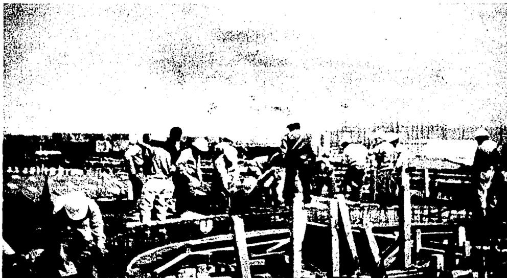
COLOCACIÓN DE CONCRETO EN LOSA AZOTEA DEL BASIN
