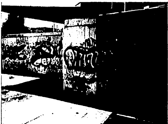
GRAFITI EN LA LATERAR DE VIADUCTO
