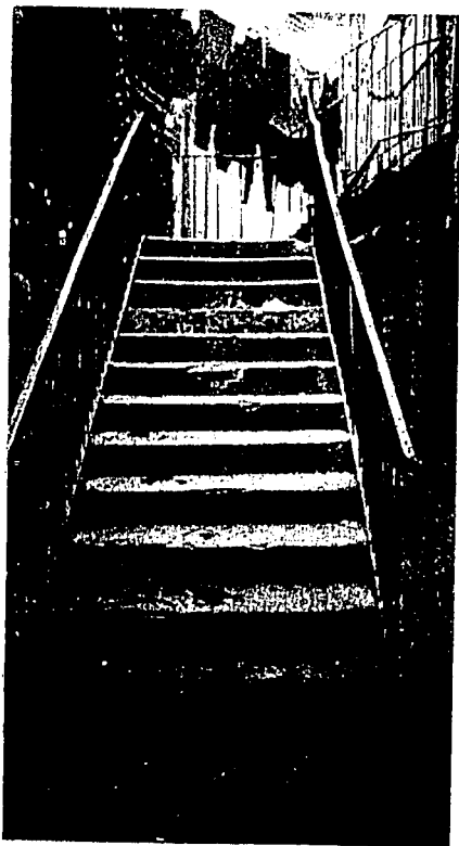
Foto M-8. Estado actual de escalera principal
