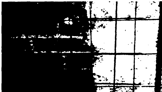
Figura 5.49 Confinamiento de un castillo con mallas metálicas traslapadas.
