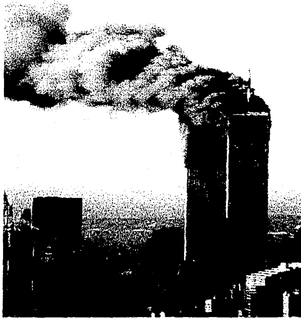
Figura 1.9. a) Daño ocasionado por explosión e incendio en Torres Gemelas de New York. Septiembre 11 del 2001
