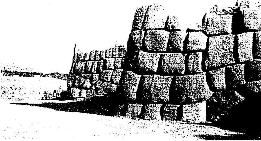
Figura 5.3 Mampostería de roca natural, labrada en formas rectangulares e irregulares, con cuatrapeo. (Foto Ing. Roberto Meli)
