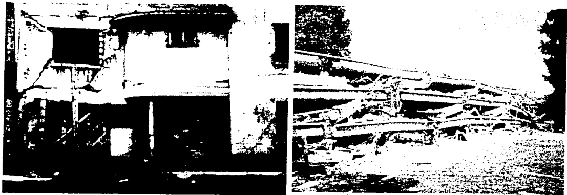
Figura 1 5 Daños provocados por sismo
