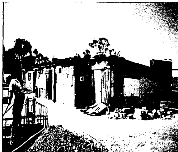
Comedor actual de operadores
