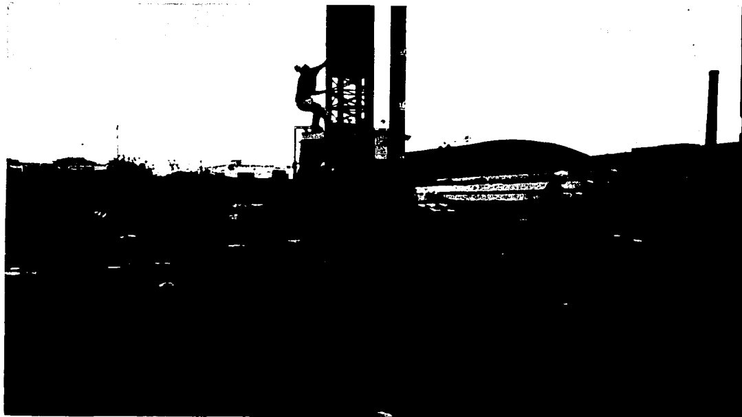
Foto VI.7. Extensión para conducir el pilote a la profundidad proyectada, se gradúa para medir dicha profundidad.
