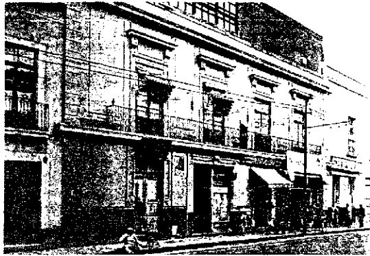
Esta casa estaba en el núm. 80 de la calle de Pino Suárez. Fue demolida en los años 30's.
