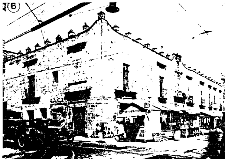
Colegio De San Ramón Nonato Ya sólo queda la fachada sobre Uruguay
