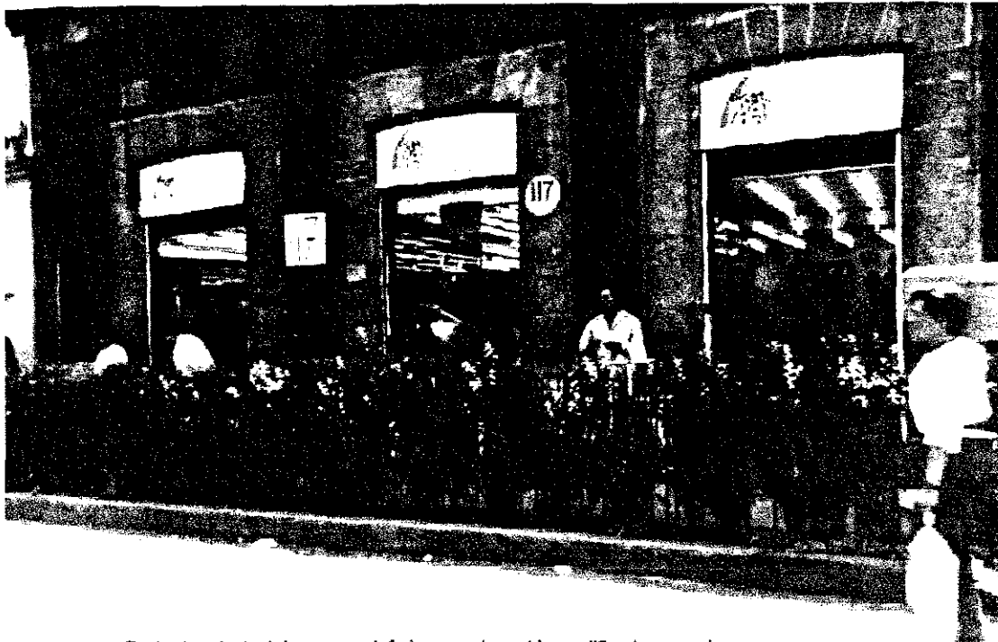
Fachada principal. Los vanos inferiores no han sido modificados, pero los acabados se muestran bastante deteriorados.
