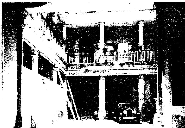
Vista del patio desde el acceso. Aquí todavía no se han cerrado del todo los muros que tapiaron el pasillo interior. Así mismo, aún no se han colocado las cortinas metálicas en los vanos.
