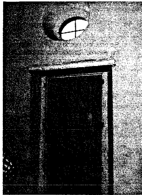
Vista interior de una de las puertas. Se observa claramente el derrame de la misma
