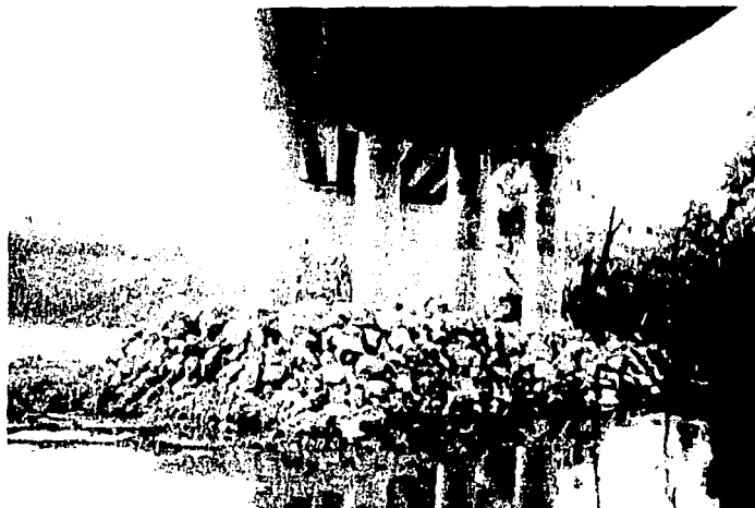
Construcción de pedraplen.
