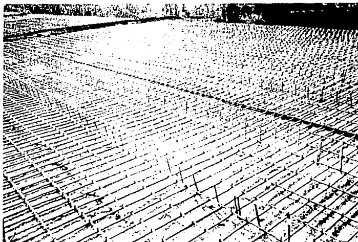
Armado de losa de compresión.
