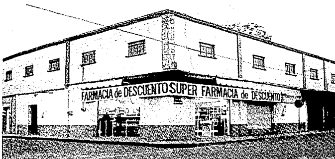
*Figura No.10 Señalización Exterior (10) *
