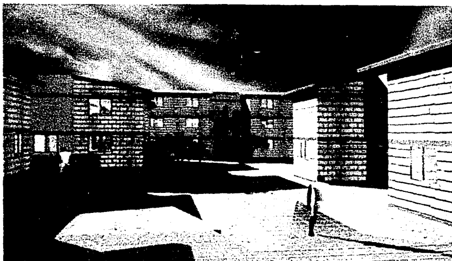
VISTA HACIA EDIFICIO DE DEPARTAMENTOS
