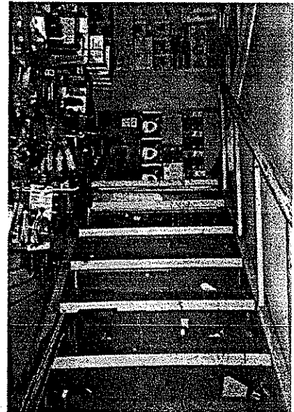
Acceso a su bodega en la planta alta
