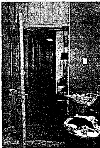
Accesos inadecuados para la recepción de insumos
