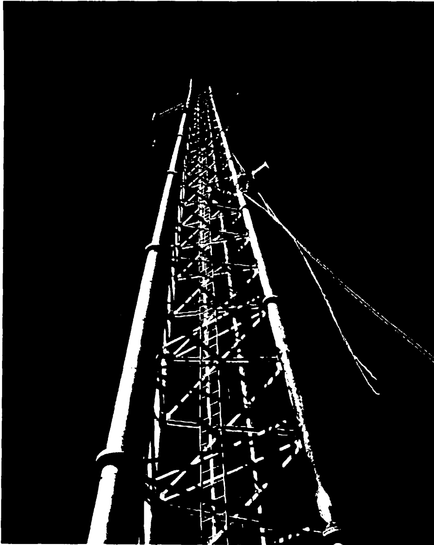
Torre autoportada esbelta de 42 metros de altura con secciones tubulares en piernas y ángulos en diagonales
