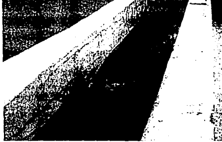
Figura 27 Carga menor a la de diseño, con salto hidráulico ahogado
