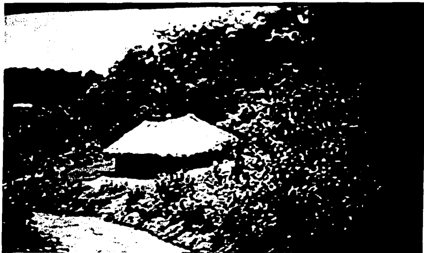
Figura 25. Vivienda tradicional construida a base de plantas locales: Brahea dulcis , Agave potatorum , Quercus magnoliifolia , Bambusa vulgaris , así como arcilla y piedras.
