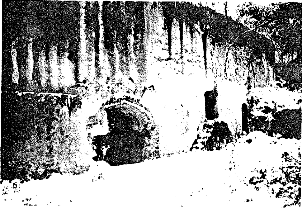
VISTA DE LAS GALERÍAS DE LOS MOLINOS HIDRAULICOS, QUE EN LA PARTE SUPERIOR CONDUCE EL AGUA POR MEDIO DE UN CANAL. OBSÉRVESE EL ARCO QUE PERMITE EL ACCESO HACIA OTRAS INSTALACIONES. HACIENDA DE SAN JUAN DE DIOS.
