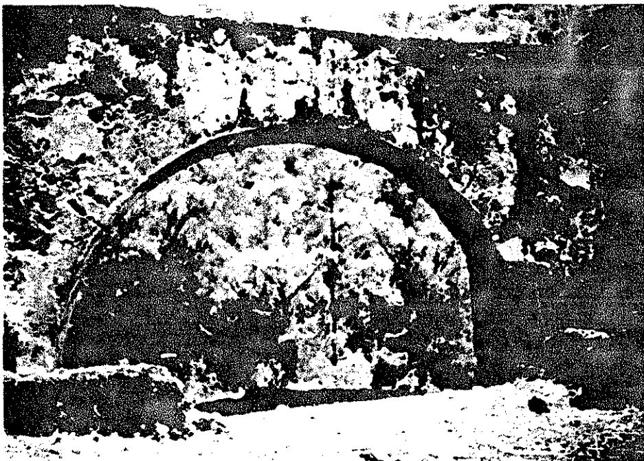
VISTA DE UNO DE LOS ARCOS QUE SOSTIENE AL CANAL QUE CONDUCE EL AGUA DENTRO DE LA HACIENDA.
