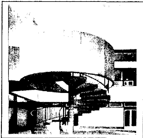
Escalera de caracol de la nueva terminal del aeropuerto de Glasgow - Inglaterra
