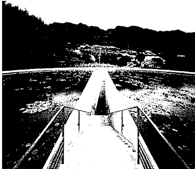
65. Vista hacia el acceso del templo.
