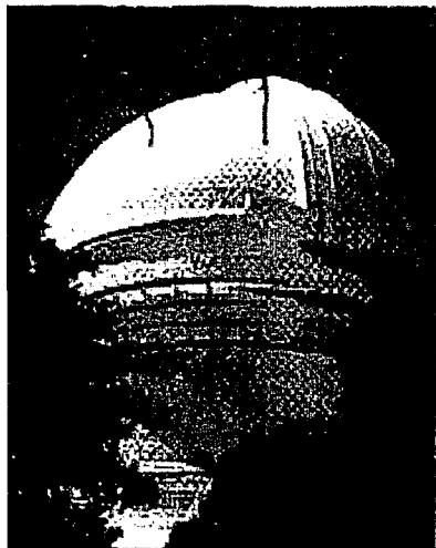
35. Edificio que alberga al telescopio de 4.00m en California Estados Unidos.
