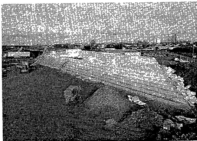
Figura 2.21 Terraplén con geoespuma (otra vista de la figura 2.20)
