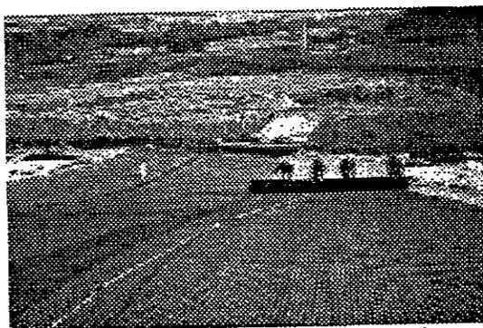
Figura 2.2 Colocación de un geosintético
