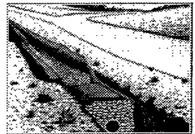
Figura 3.17 Empleo de geotextiles en trincheras drenantes
