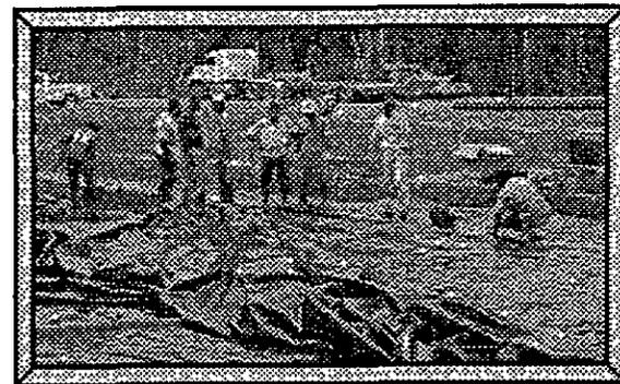
Figura 4.13 Habilitado de una geomembrana
