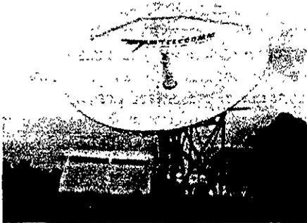
Figura 3.54 Arreglo Cassegrain para alimentar un reflector parabólico de una estación terrena
