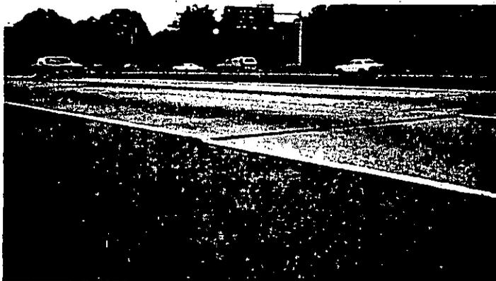
**FIGURA 1.1.2 FALLA ESTRUCTURAL POR FALTA DE SOPORTE DE LA SUBBASE**
