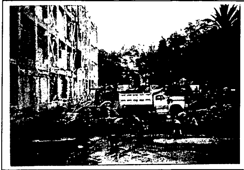
Limpieza de terreno
