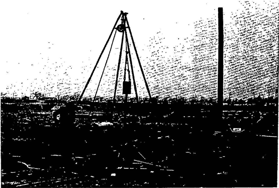
Fig. 3.5. Equipo con trípode para pruebas de penetración estándar.
