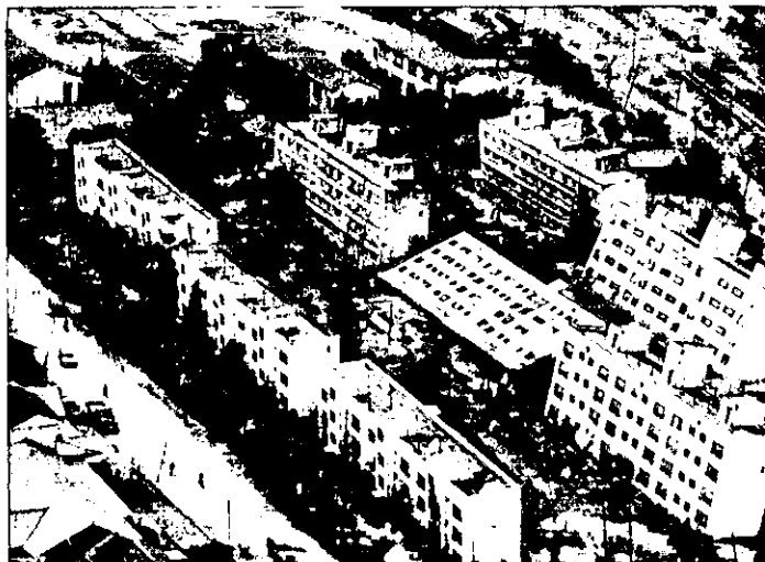
FIG 1.4 Efectos causados por la licuación en el sismo de Niigata en 1964 (Kramer, 1966)
