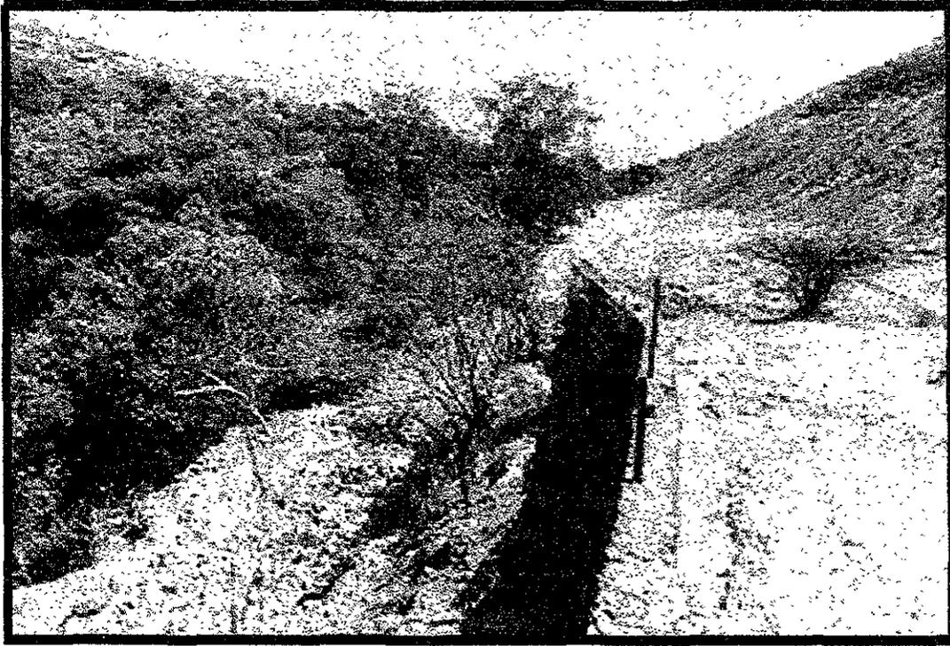
**Figura 8 - Muro de retención de los jales el Fraile. Note que el reten es insuficiente y la dispersión mecánica de los desechos ha alcanzado el cauce del Río Cacalotenango.**
