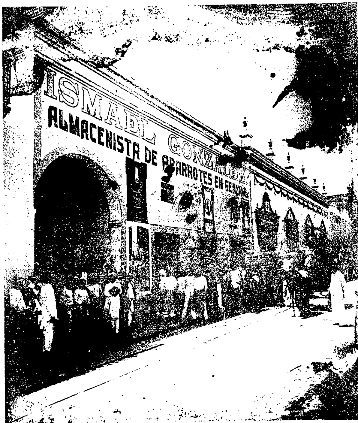
Entrada sobre la calle 60 del edificio de La Placita, mercado construido a base de portales durante la época borbónica, y que hasta la fecha mantiene más o menos su función original con un nuevo edificio que alberga también las oficinas del Catastro Estatal.
