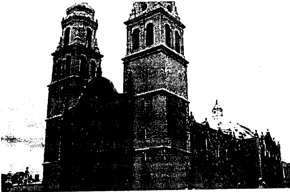
Catedral de la Inmaculada Concepción de Campeche que según las crónicas fue iniciada en 1542, antes de 1650 se inició la construcción de la que aparece la fotografía.
