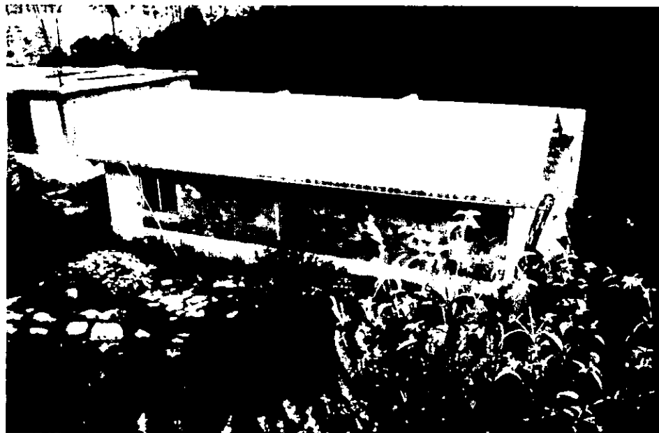
Foto No. 1 Instalación para el cultivo de hongo seta construida con tabicón y lámina, clasificada en este estudio como una de las más apropiadas.
