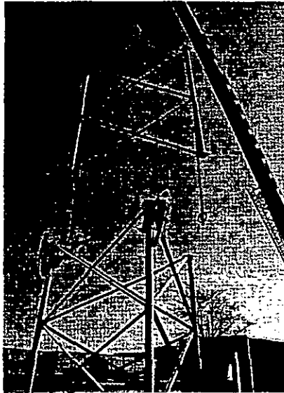
Figura: V. 1. 1. Montaje de Torre Autosoportada.
