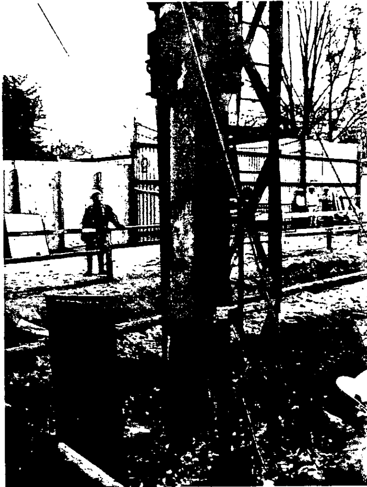
En la fotografía se aprecia el proceso de hincado del pilote en su parte inicial.
