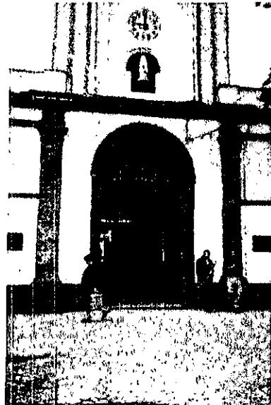
FACHADA PRINCIPAL FOTO TOMADA DESDE LA BANQUETA DE AV. DE LOS AHUEHUETES
