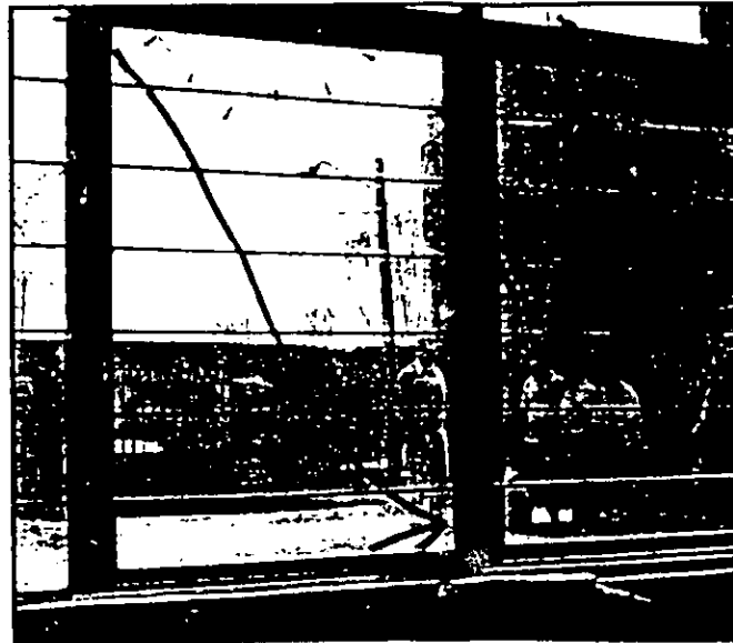
Las constantes detonaciones provocan que se rompan los vidrios.
